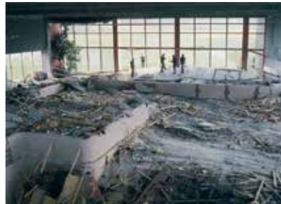
1985 u Švicarskom mjestu Usteru u jednom zatvorenom bazenu došlo je do pada obješenog betonskog stropa (deke). Ovjesi deke od nehrđajućeg A2 čelika nisu pokazivali prema vani nikakav nedostatak, dok su unutra bili djelomično ili potpuno razoreni naponskom korozijom.
